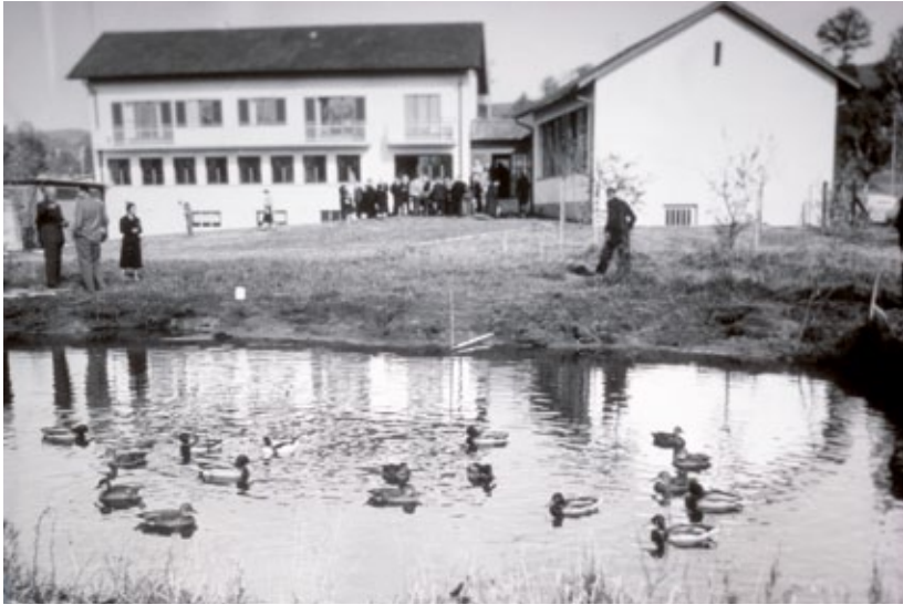
Das erste eigene Gebäude der Vogelwarte 1955 bei der Einweihung.
